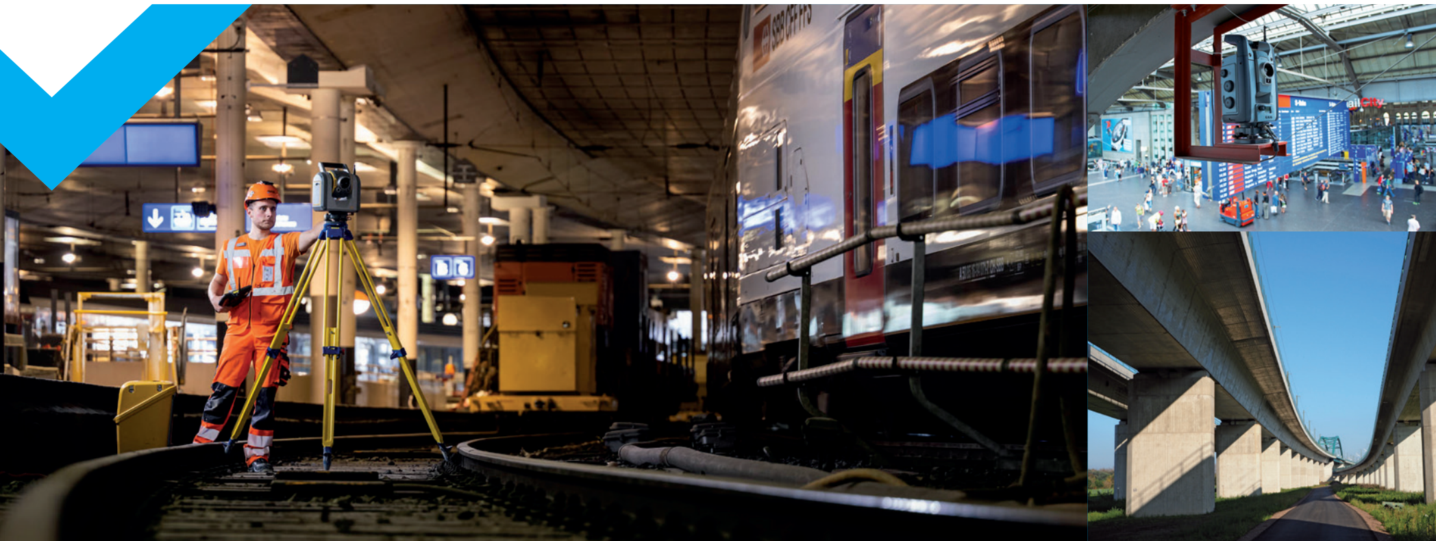
Vermessungs- und Monitoringdienstleistungen beim Bahnhof Bern
